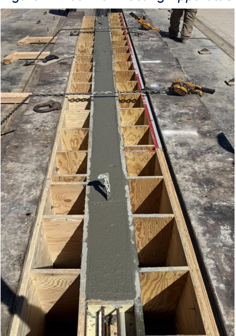
Figure 6: Form Concrete Pour
